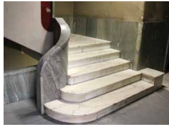
Alcuni particolari dei locali interni della Borsa Merci rivestiti di Cipollino proveniente dalle cave della Versilia.
